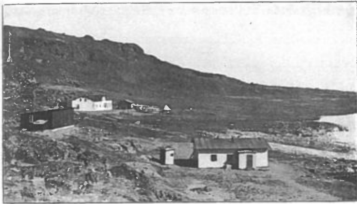
Fig. 8. Ansicht der Arktischen Station von Westen. Rechts im Vordergrund Wohnung der Arbeiter. Linkes dunkles Häuschen seismologisches Observatorium. Hinter demselben das Hauptgebäude mit der Werkstätte. Rechts von der letztern astronomische Beobachtungsstation. Im Hintergrunde Basaltzug des Östertales, rechts in die Strandterrasse übergehend. Photogr. v. M. P. Porsild 1909.
